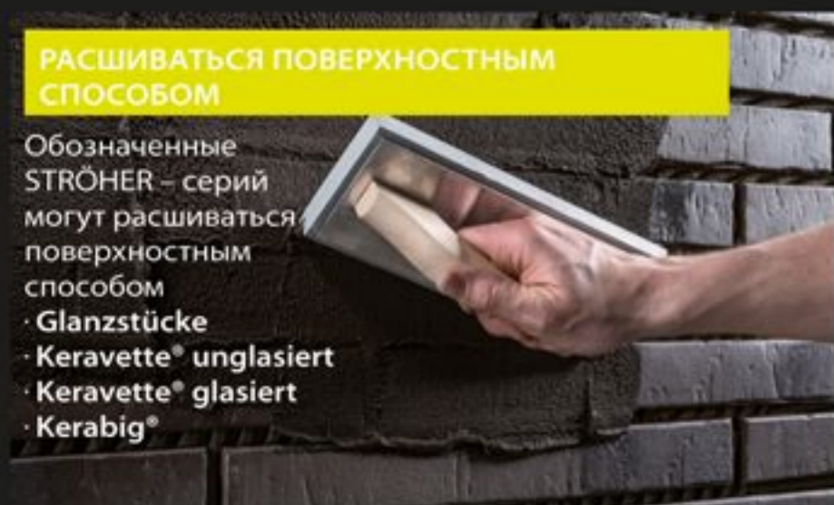
По методу поверхностной затирки швы заделываются с помощью расшивочной или штукатурной рейки. Настенные поверхности обрабатываются сверху вниз.
