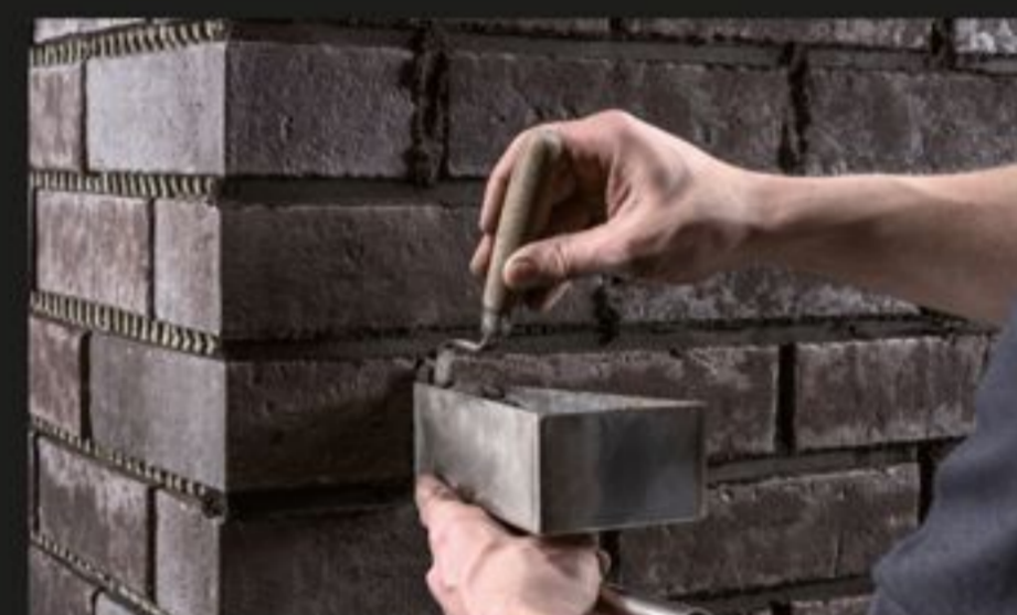
Вертикальные швы проще расшиваются с помощью шпателя меньших размеров для расшивки швов.
