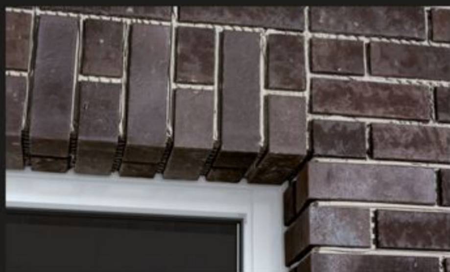
Оконный откос, превосходно выполненный с помощью углового элемента.
