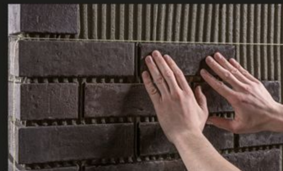
Укладка плоских клинкерных плиток с помощью шнура. Клинкерные плитки вдавливаются в слой клея.
