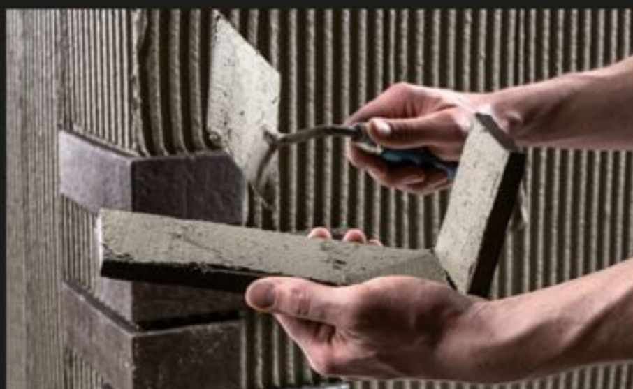
С уголками работают по методу двойного намазывания.
