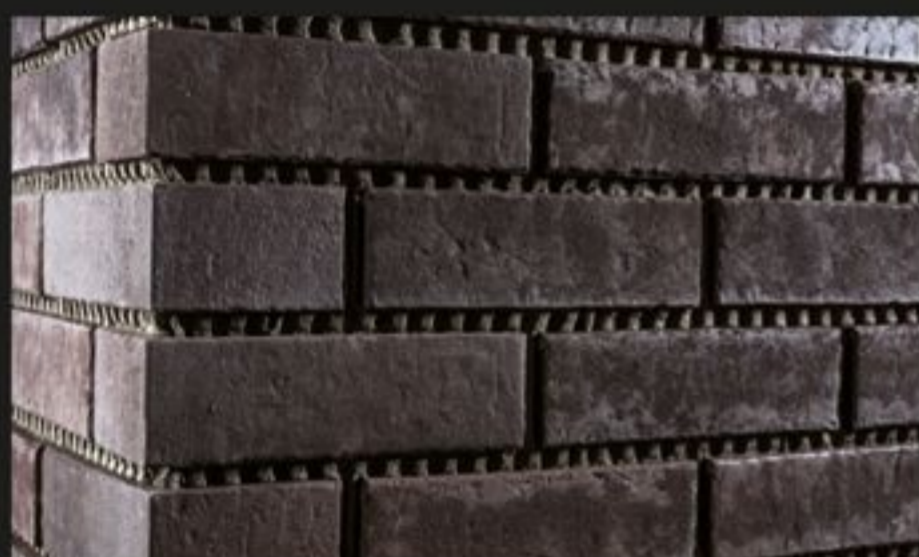
Полностью облицованная поверхность. После времени выдержки можно приступать к расшивке швов.
