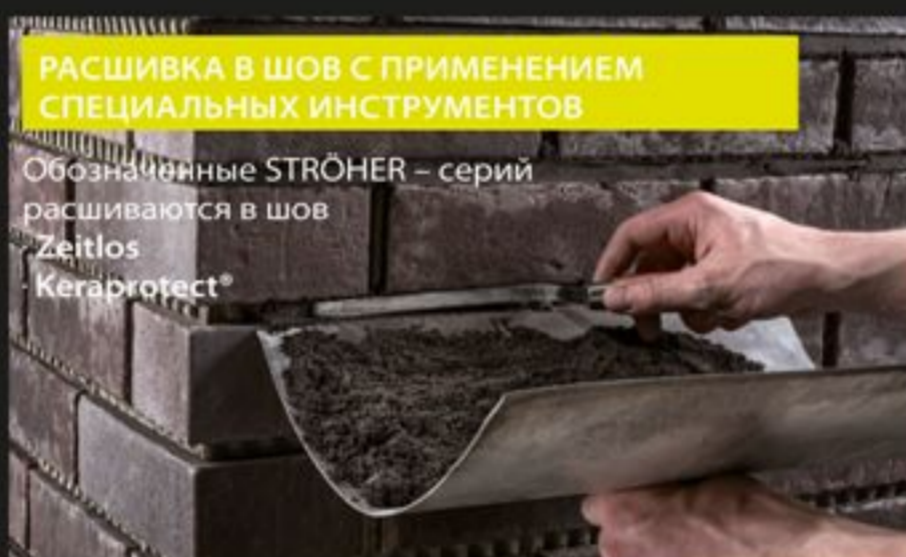
Расшивка с помощью мастерка для расшивки швов в горизонталях.
