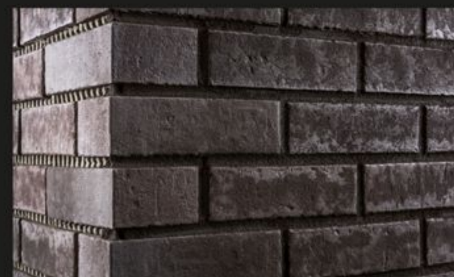
Вид готового шва. Всегда полностью расшиваются все стороны.
